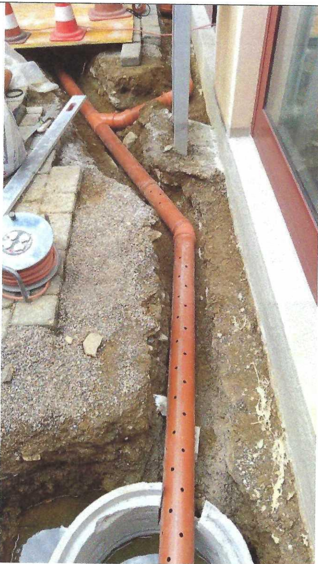
Risanamento, e drenaggio con pozzetti e condotte all'esterno – agosto settembre 2025
