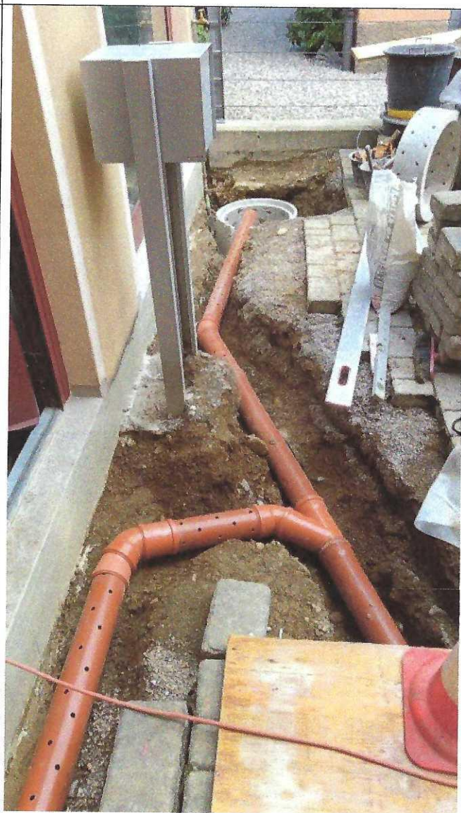
Risanamento, e drenaggio con pozzetti e condotte all'esterno – agosto settembre 2025
