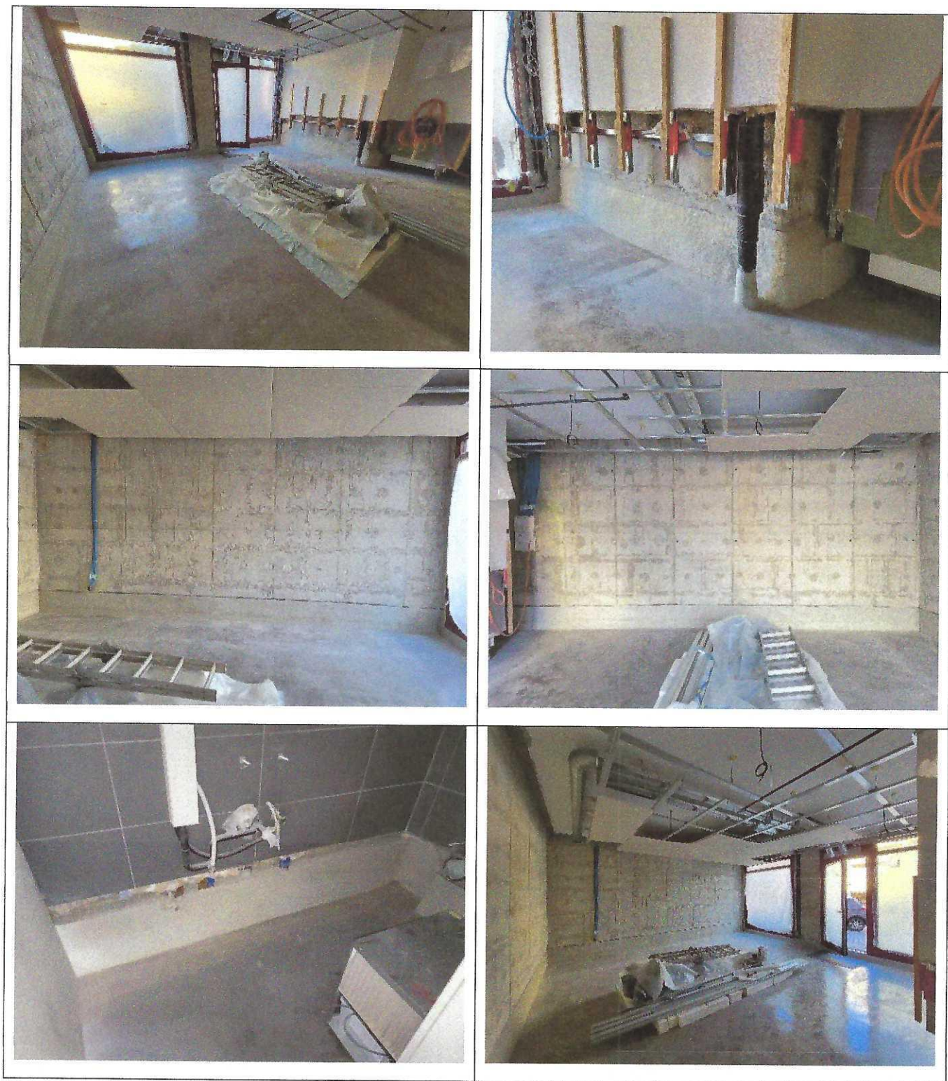
Risanamento e impermeabilizzazione all'interno- luglio agosto 2025
